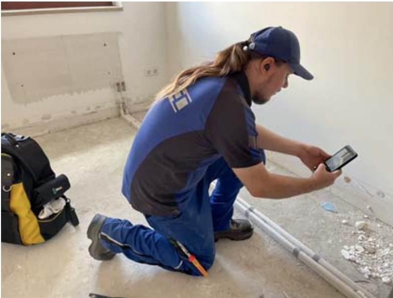
Techniker Kevin Czarnowski dokumentiert den Baufortschritt mit Fotos in Label Mobile
