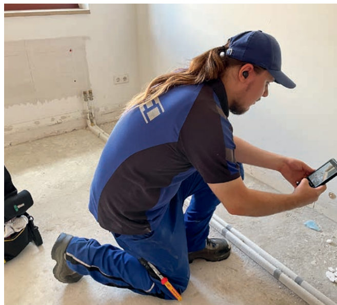
Bild 5: : Techniker Kevin Czarnowski dokumentiert den Baufortschritt mit Fotos in Label Mobile
