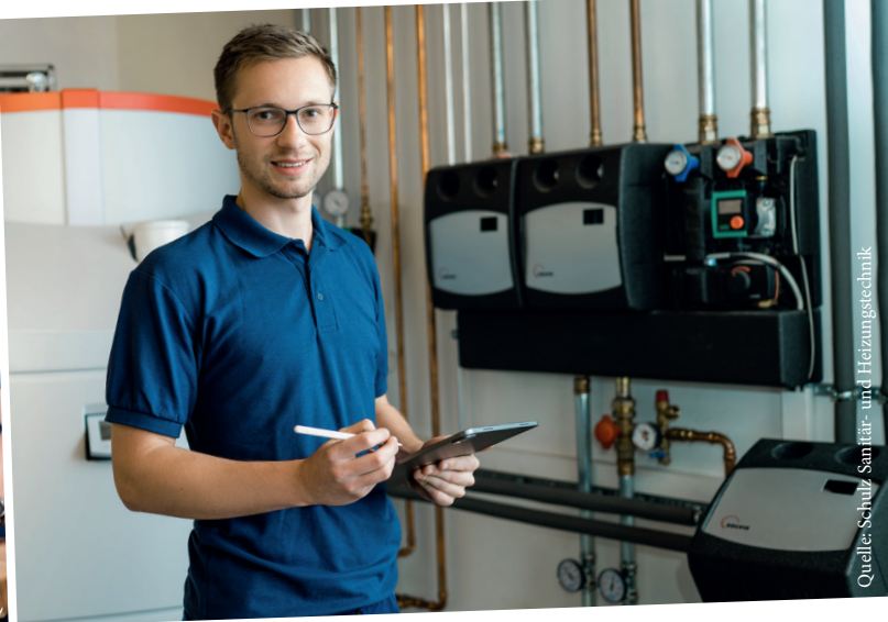
Installateur- und Heizungsbauermeister Jonathan Schulz bei der Arbeit.
